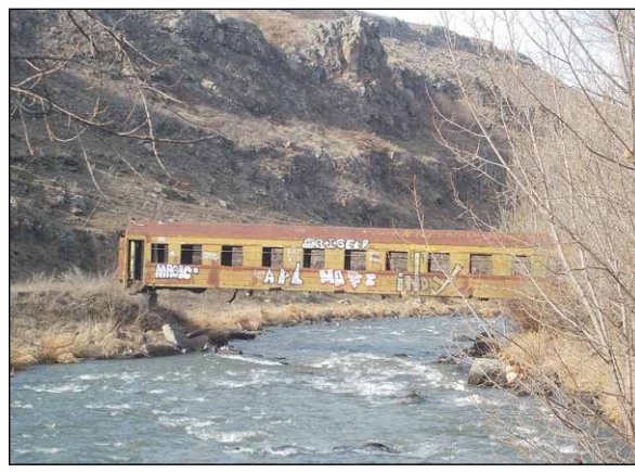
Grúz találékonyság, avagy: híd a Kwai Paravani-folyó fölött, vasúti kocsiból (Ahalkalaki után, Grúzia).
